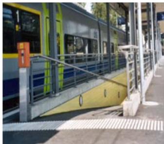
Marquage au sol (marquage des escaliers)
